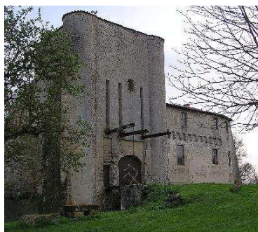
Fig. 88 : Château de Villeneuve-la-Comtesse (Source :Wikipédia)
